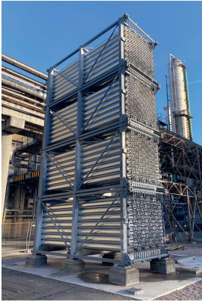
Blick auf den unverschalteten Wärmespeicher aus Karbonstahl und dem Spezialbeton HEATCRETE®, der in Zusammenarbeit mit HeidelbergCement entwickelt wurde.
